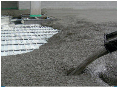
Colado de hormigón con la adición de Mapefibre NS18 para contrarrestar el agrietamiento por contracción plástica
