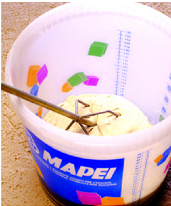
Mezcla de Mapeiset Interiores con mezclador mecánico
